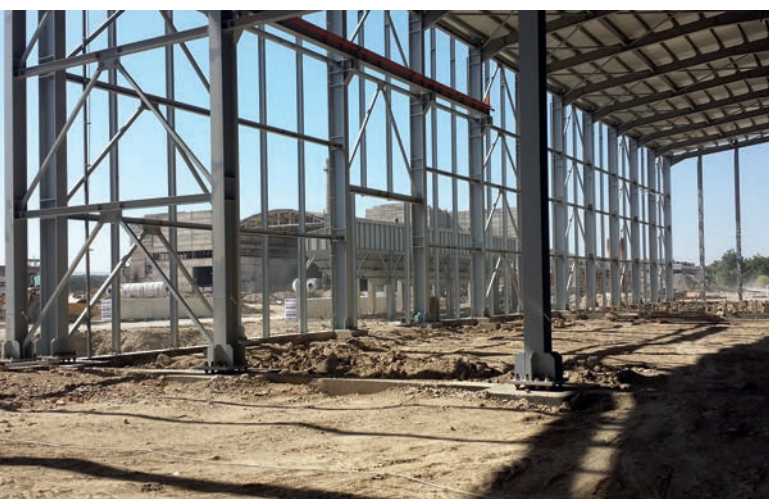
Уже спустя 10 недель после начала строительства на участке выросли первые цеховые постройки
