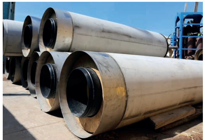
Склад временного хранения труб для микротоннелирования Perfect Pipe на стройплощадке
