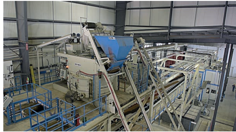
Смесители для опорного и облицовочного бетона
