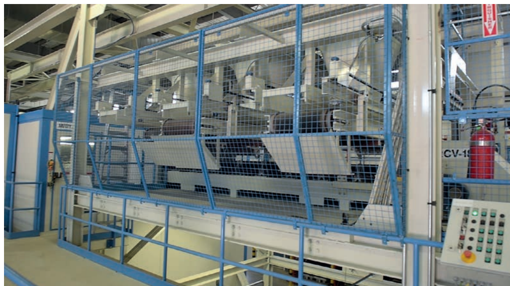
Дозирующие ленточные транспортеры для облицовочной бетонной смеси
