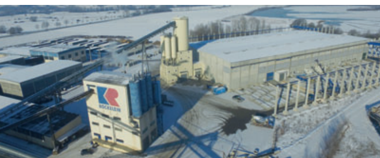
La sede Röckelein di Rattelsdorf con il capannone di produzione a due navate dalla prospettiva a volo d'uccello costruito nel 2012
