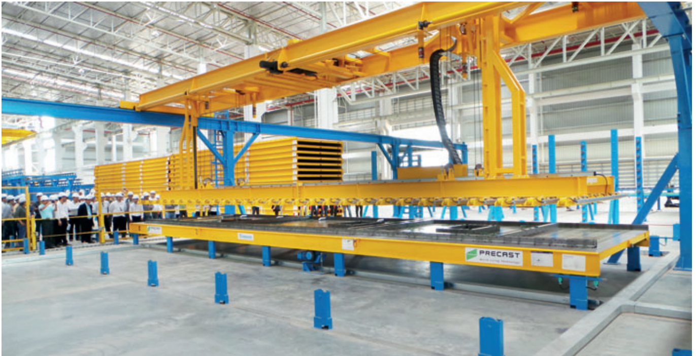
La nouvelle usine mise sur l'automatisation : la préparation automatique des treillis et leur mise en place dans les palettes coffrées sont assurées par un palonnier de manutention.
