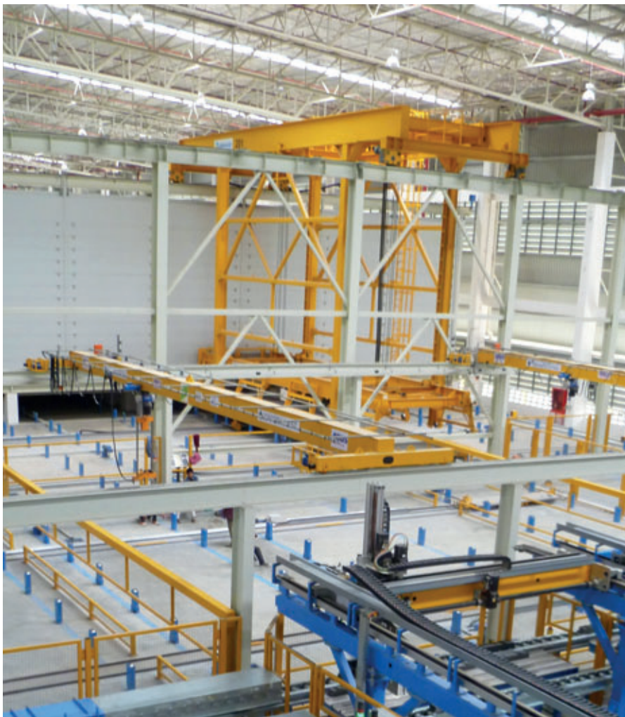
Un transstockeur automatique assure la mise en place et le prélèvement des palettes. ebos calcule la durée de séjour nécessaire dans les rayonnages de séchage et transmet ces données à la machine.
