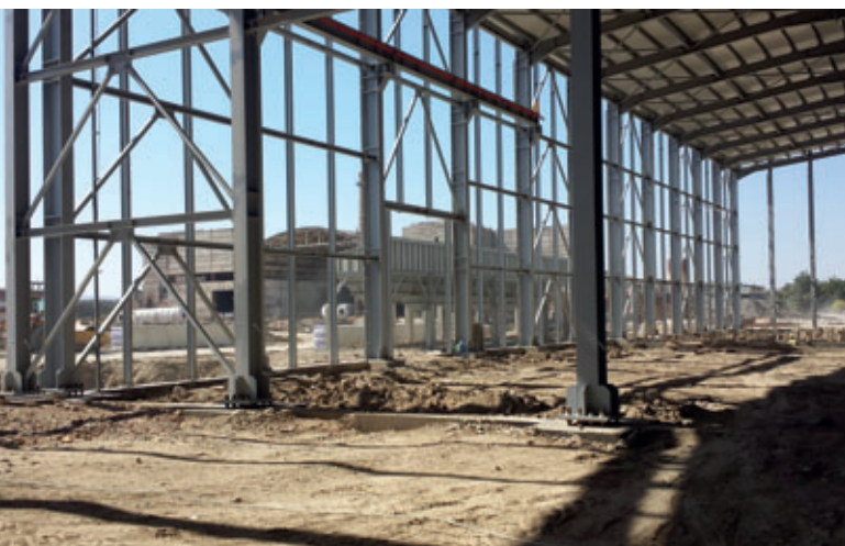
Al cabo de tan solo 10 semanas desde el comienzo de las obras ya se erigieron las primeras naves de la fábrica
