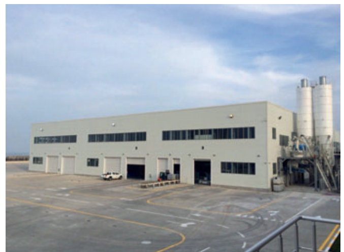
Las nuevas naves de la fábrica se han construido en muy poco tiempo siguiendo las instrucciones de Prinzing-Pfeiffer
