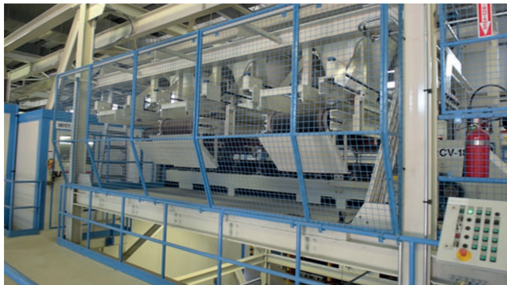
Cintas dosificadoras para la mezcla del hormigón bicapa
