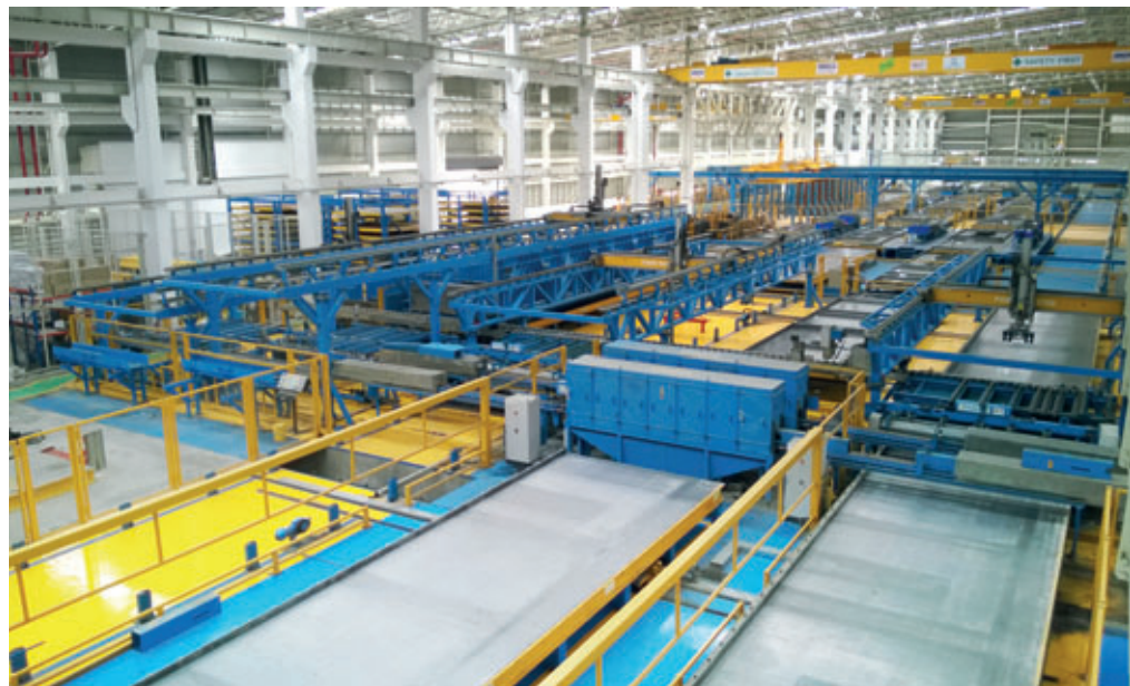
Blick in das neue Hochleistungswerk bei Pruksa: Das Entschalen und Schalen der Paletten sowie das Reinigen und Ölen der Paletten und der benötigten Schalungsabsteller ist komplett automatisiert.
