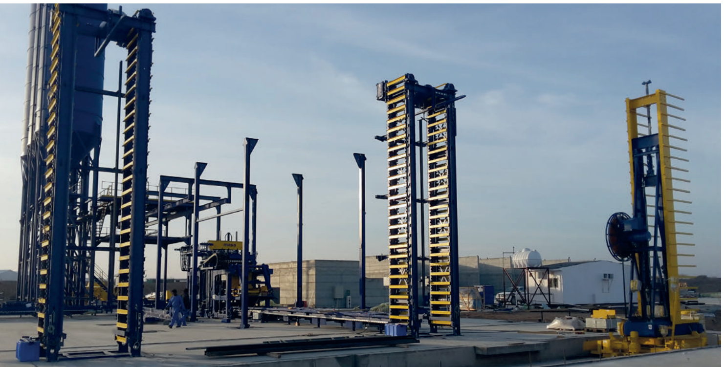
Монтажные работы: установка погрузочно-разгрузочного устройства и сборка вилочного погрузчика Masa
