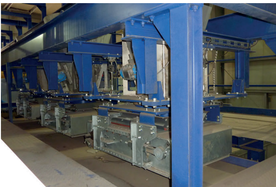
Во время дозирования цветного бетона конвейерные ленты могут поворачиваться на 30° влево и вправо относительно центральной оси
