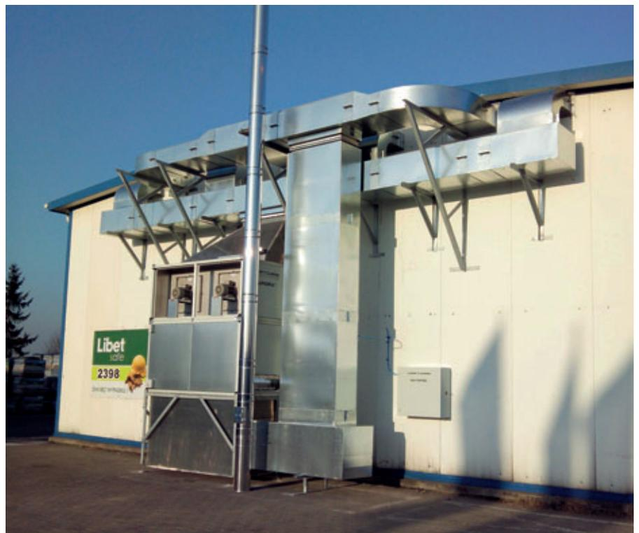
L'ensemble de l'installation compacte Quadrix® a été installée à l'arrière de la chambre de durcissement isolée. Cette installation a été enfermée et isolée avant l'hiver. Les canaux isolés permettent de réduire le besoin en énergie. L'appareil de chauffage et la cheminée sont revêtus à l'intérieur d'acier inoxydable de grande qualité.
