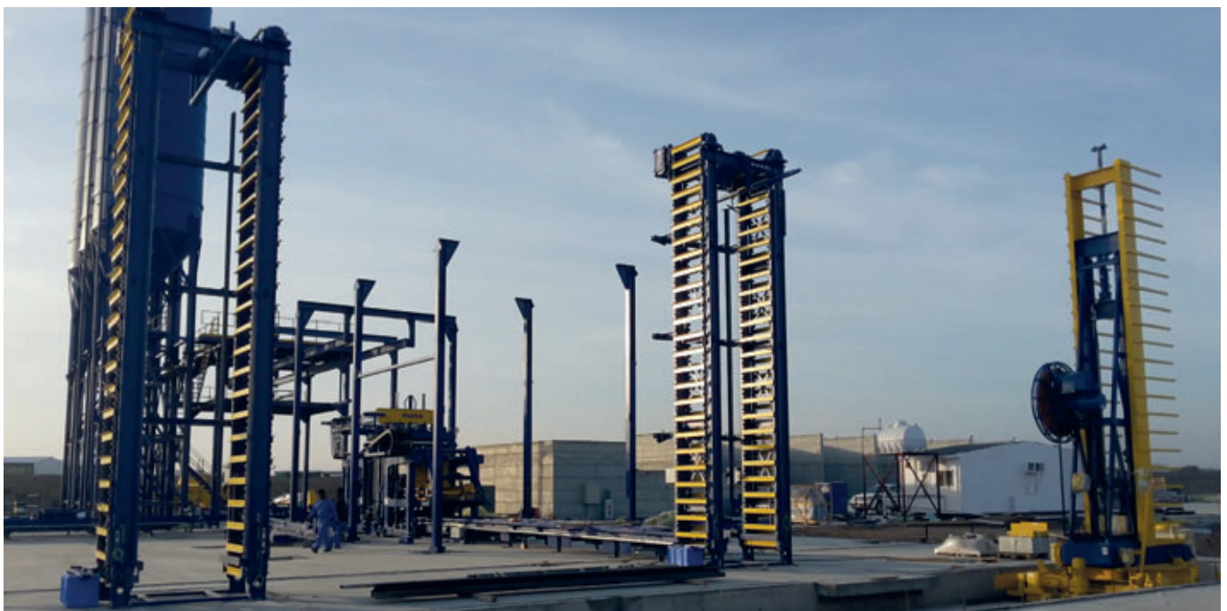
Les travaux d'installation progressent : les ascenseurs et descendeurs ainsi que le chariot élévateur Masa sont montés
