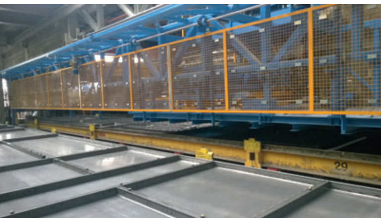
Principe du coffrage au centimètre : coffrage sans aucune faille ni éléments de remplissage
