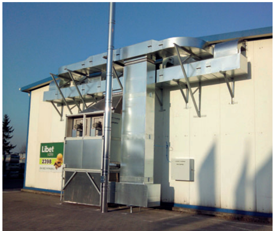
La instalación Quadrix® compacta fue instalada completamente en la parte posterior de la cámara de curado aislada. Esta instalación fue alojada en un recinto cerrado. Los canales aislados reducen el consumo de energía. El calentador, así como la chimenea están revestidos por dentro con acero inoxidable de alta calidad.
