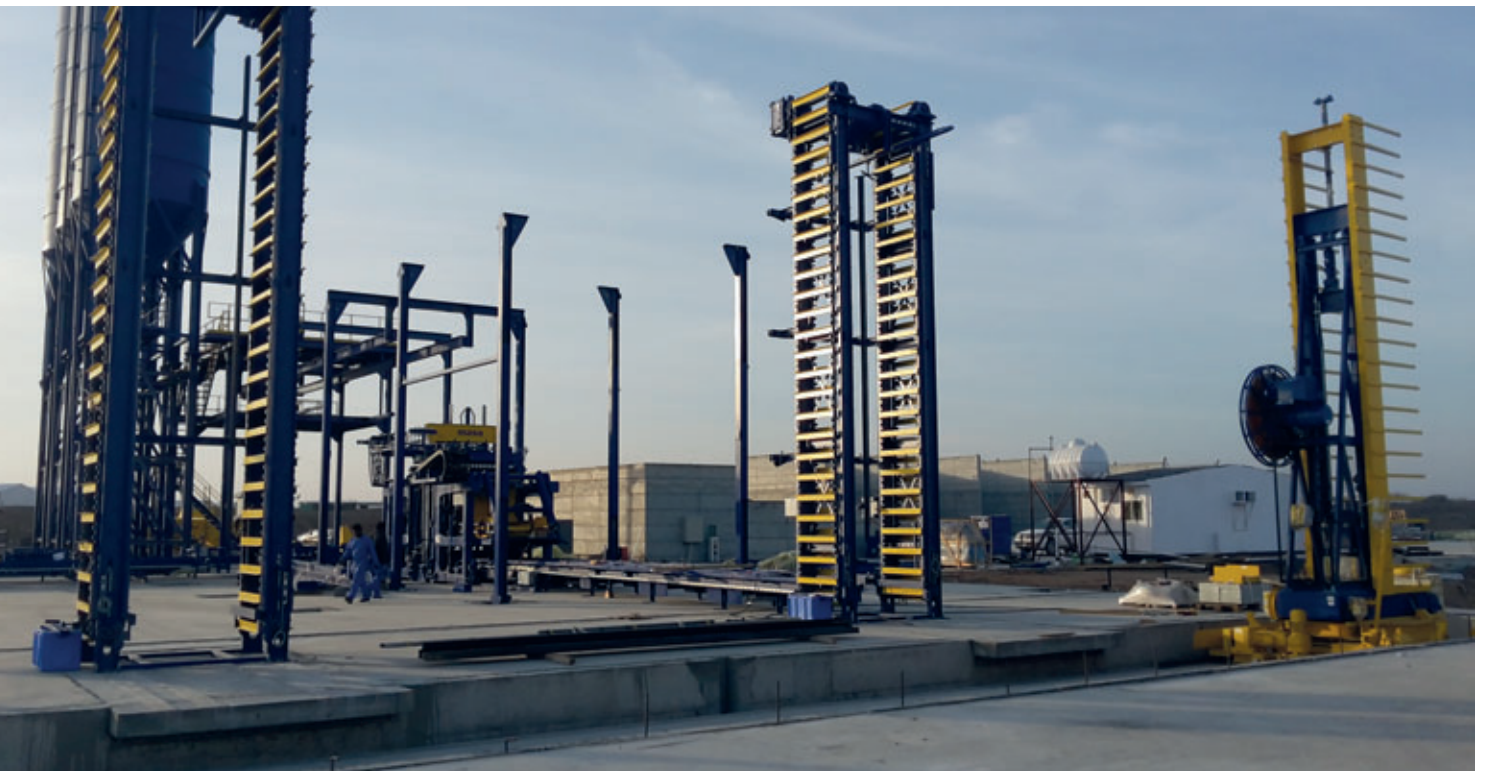
Los trabajos de instalación avanzan: ya están montados el ascensor, el descensor, así como el carro multiforca Masa
