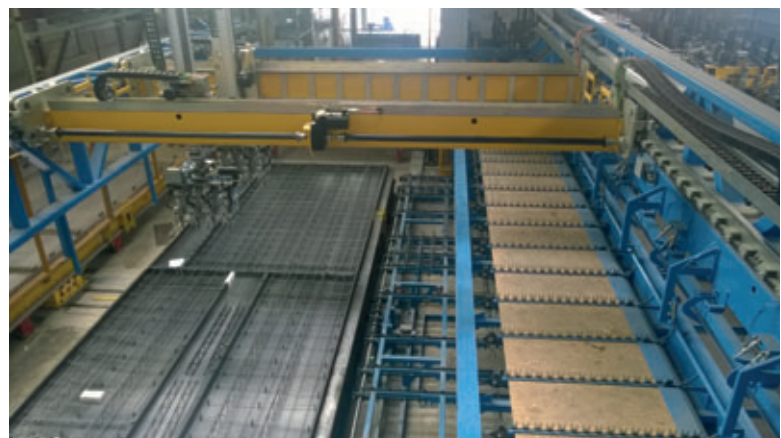
Wire Center: Procesamiento automático de acero con robot
