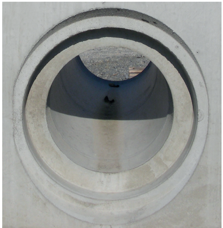
Диаметр отверстий под патрубки может варьироваться от DN100 до DN1000
