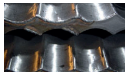
Figura 2: Soldadura del borde inferior del molde antes y después
