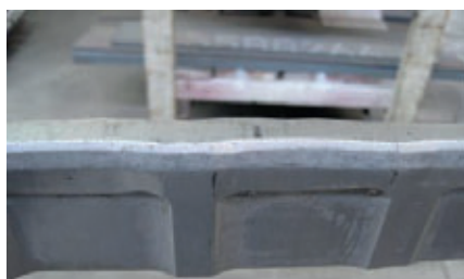
Figura 5: Fuerte desgaste en el borde superior del molde
