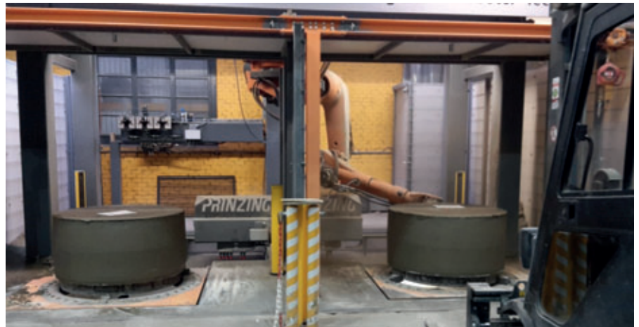
Doppelfrässtationen mit 2 Fräsrobotern (ein Roboter oberhalb angeordnet, ein Roboter unter Flur)
