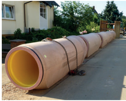
В Гессене используется труба номинальным внутренним диаметром DN800
