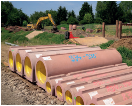
Трубы и элементы шахт различного диаметра, изготовленные по технологии Perfect
