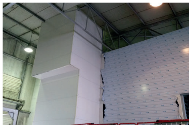
Обшивка подъемника теплоизоляционными панелями до начала отделочных работ. На изоляцию стены потребовалось 5 дней
