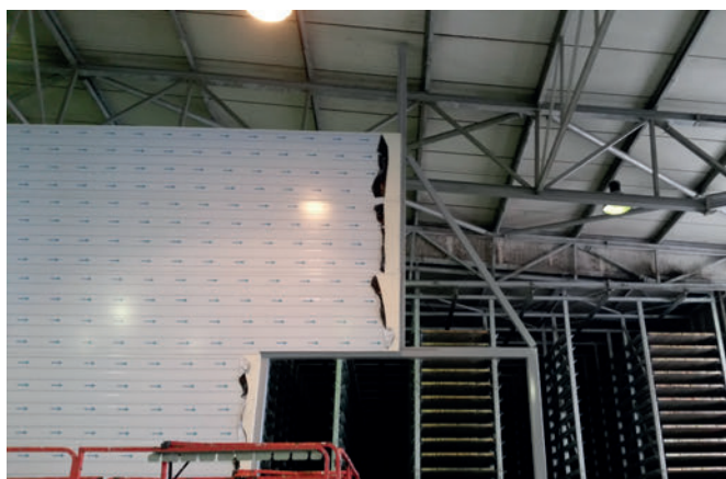
Монтаж металлоконструкций и теплоизоляционных панелей для разделения участков производства и выдержки
