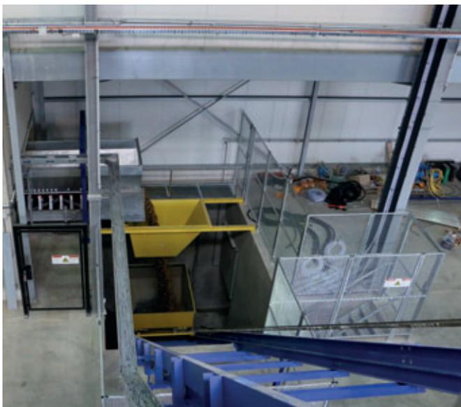
*Il montacarichi è dotato di avviamento soft e porta gli aggregati al livello superiore del miscelatore.*
