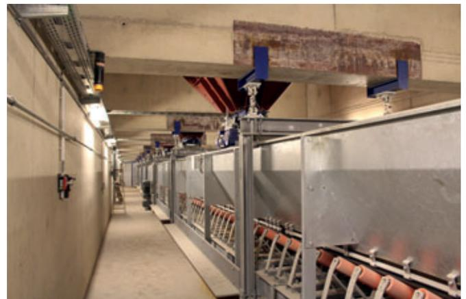
*Gli aggregati vengono dosati da due silos su un nastro trasportatore, dal quale vengono trasportati nel vagonetto elevatore.*
