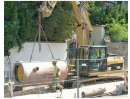
*Diversi tubi ceramici vecchi vengono sostituiti da un nuovo collettore DN1000.*
