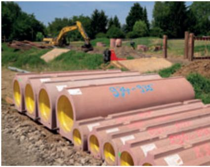
*Varietà di elementi per pozzetti e tubi di diversi diametri nominali, realizzati secondo il processo Perfect.*
