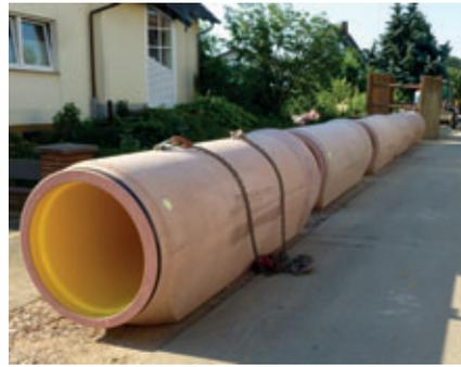
*Nel primo progetto, nello stato federato tedesco dell'Assia, trova applicazione Perfect Pipe con diametro nominale DN800.*
