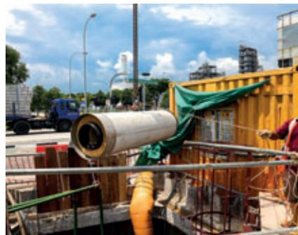
*I vantaggi dei tubi in calcestruzzo, l'elevata portata statica e la robustezza adatta alla quotidianità del cantiere, sono stati ulteriormente potenziati con uno spessore della parete del tubo di 130 mm.*
