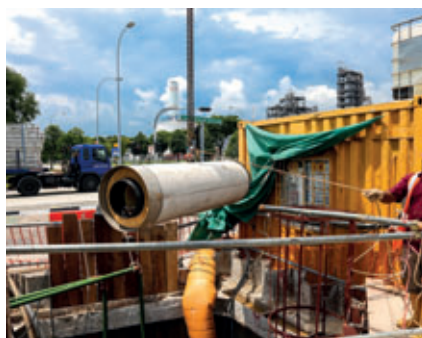
Les avantages des tuyaux en béton, à savoir une grande résistance statique et une grande robustesse pour les exigences quotidiennes sur chantier, ont été encore renforcés par le choix d'une épaisseur de paroi de 130 mm.
