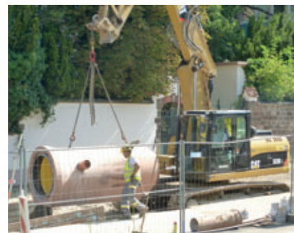
De vieilles conduites en céramique sont remplacées par un nouveau collecteur de diamètre 1000.
