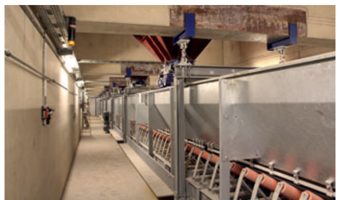
Les granulats sont dosés à partir des silos, puis déposés sur une bande transporteuse pour être amenés vers l'élévateur de bennes.
