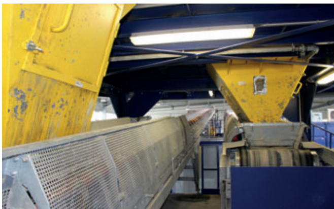
Les mélangeurs se déchargent sur les bandes transporteuses qui amènent le béton vers la machine de production de blocs
