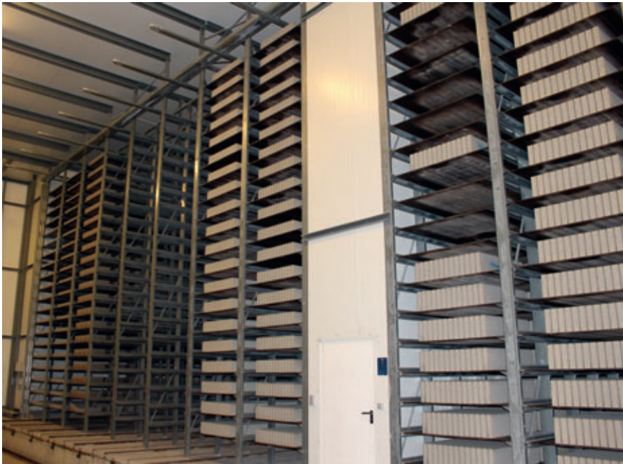
La chambre de durcissement montée chez Rewa possède, en tout, 16 chambres de 20 étages chacune, ainsi qu'une chambre supplémentaire vide.
