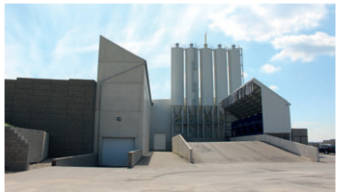
Les deux installations de silos pour les granulats (à gauche pour le béton de remplissage et à droite pour le béton de parement)
