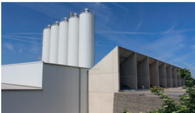
La nouvelle usine de béton de la société Rewa à St. Vith en Belgique
