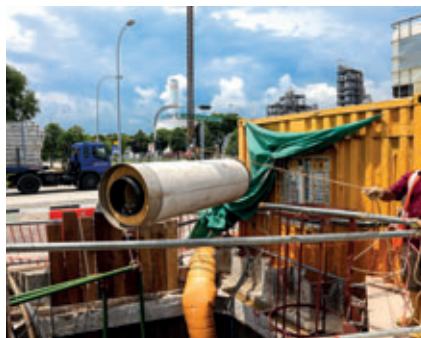
Las ventajas de los tubos de hormigón – elevada capacidad de carga estática y resistencia para el día a día en la obra – se han reforzado de nuevo con un grosor de pared de 130 mm.
