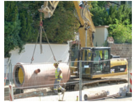
Sustitución de varias líneas de tubos de cerámica antiguas mediante un nuevo colector DN1000.
