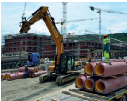
La adjudicación de este proyecto tuvo lugar con gran celeridad gracias a las evidentes ventajas para la instalación de Perfect Pipe.
