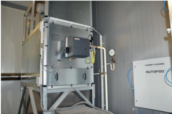
La unidad Quadrix® tiene una superficie de instalación de 1400 mm x 2400 mm y se puede instalar sobre, detrás o al lado de la cámara de curado. Todos los componentes internos, como la cámara de combustión y el intercambiador de calor, son de acero inoxidable. En la pared (a la derecha), el sistema de humidificación AutoFog™ (un aparato compacto montado en la pared con unas dimensiones de 600 mm x 600 mm) con 10 microtoberas se encarga de proporcionar la humedad en forma de una niebla fina
