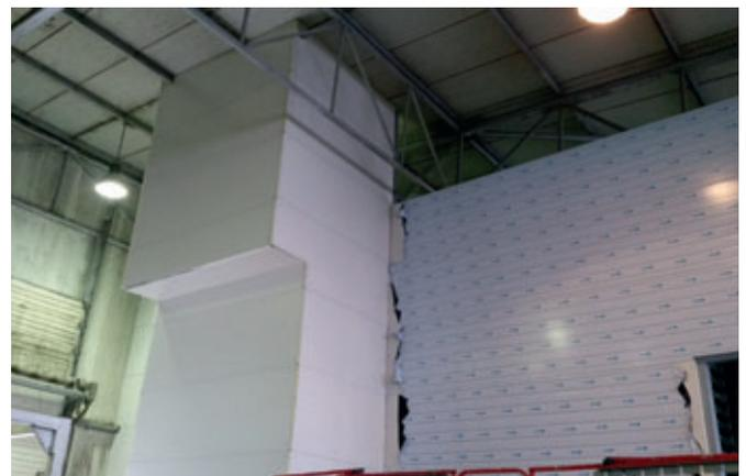
Instalación de placas aislantes alrededor del elevador antes de la finalización de los trabajos de acabado. Para aislar la pared se tarda, en total, 5 días laborables.
