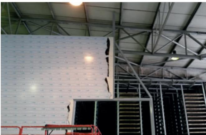
Instalación de marcos de acero y placas aislantes para la pared aislante entre la zona de producción y de curado.
