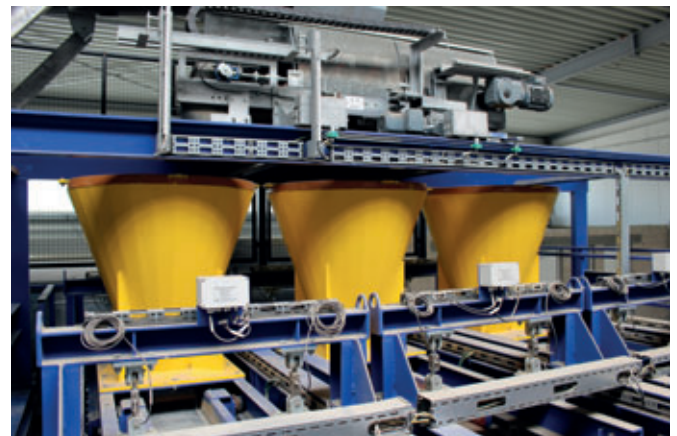
Sistema Color-Mix con 3 silos y cintas de dosificación desplazables
