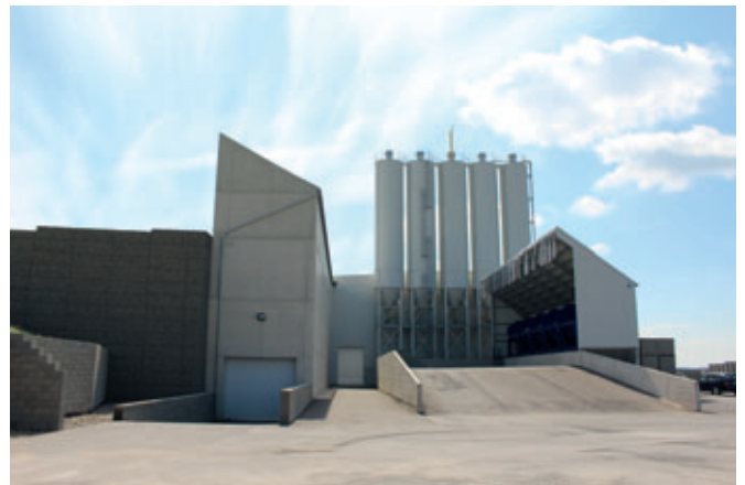
Las dos instalaciones de silos para áridos (izquierda: hormigón monocapa, derecha: hormigón bicapa)
