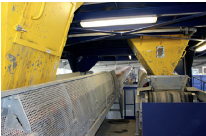
Las mezcladoras descargan sobre cintas transportadoras, que transportan el hormigón a la máquina bloquera
