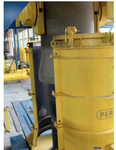
Nach dem Erhärten in der Form werden die Betonrohre entschalt und die Connectoren jeweils an einem Rohrende montiert.
