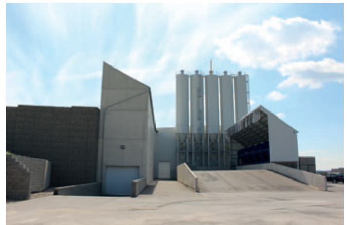
Die zwei Siloanlagen für die Gesteinskörnungen (links: Kernbeton, rechts: Vorsatzbeton)
