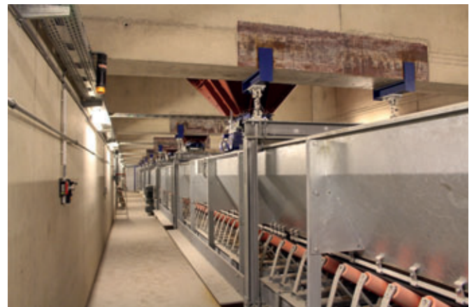
Die Gesteinskörnungen werden aus den Silos auf ein Förderband dosiert und von diesem in den Aufzugkübel befördert.
