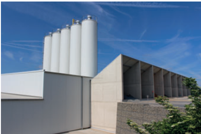
Das neue Betonwerk von Rewa in St. Vith, Belgien
