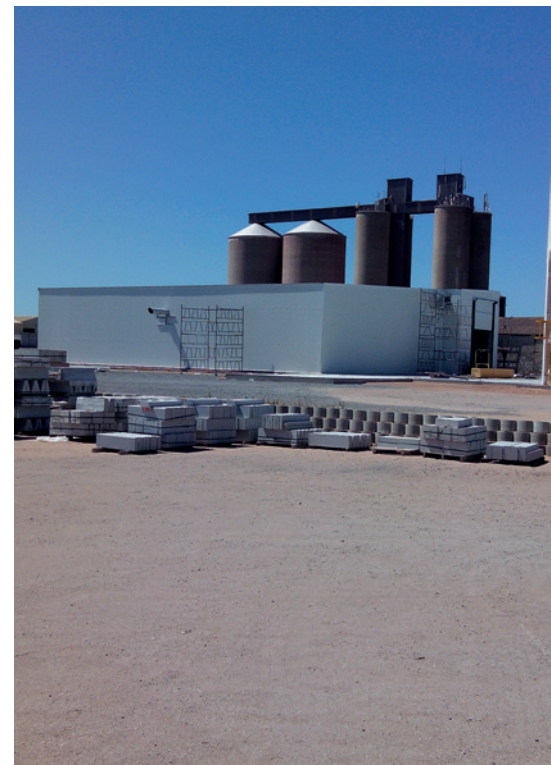
Наружная изоляция камеры, стальные направляющие, автоматические двери и система циркуляции воздуха
