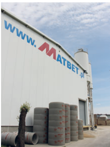
Lo stabilimento di produzione di calcestruzzo dell'azienda Matbet a Tarnowo Podgórne, Polonia
