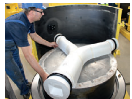
Implantation d'un négatif de cunette prêt dans un moule en acier
