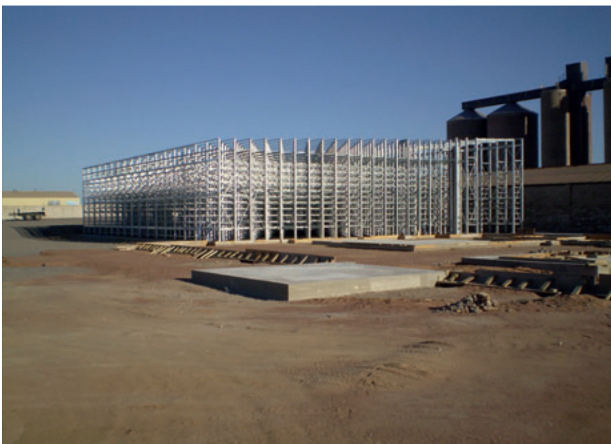
Sistema de estanterías de acero galvanizado de Kraft
