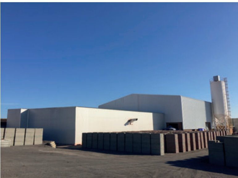
Fábrica completa con cámara de curado antepuesta (edificio más bajo)
