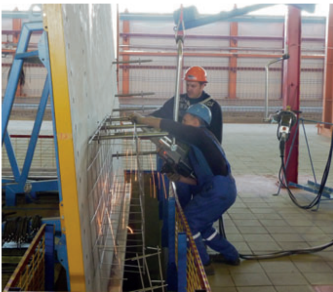
Máquina soldadora vertical para soldar jaulas de armadura
