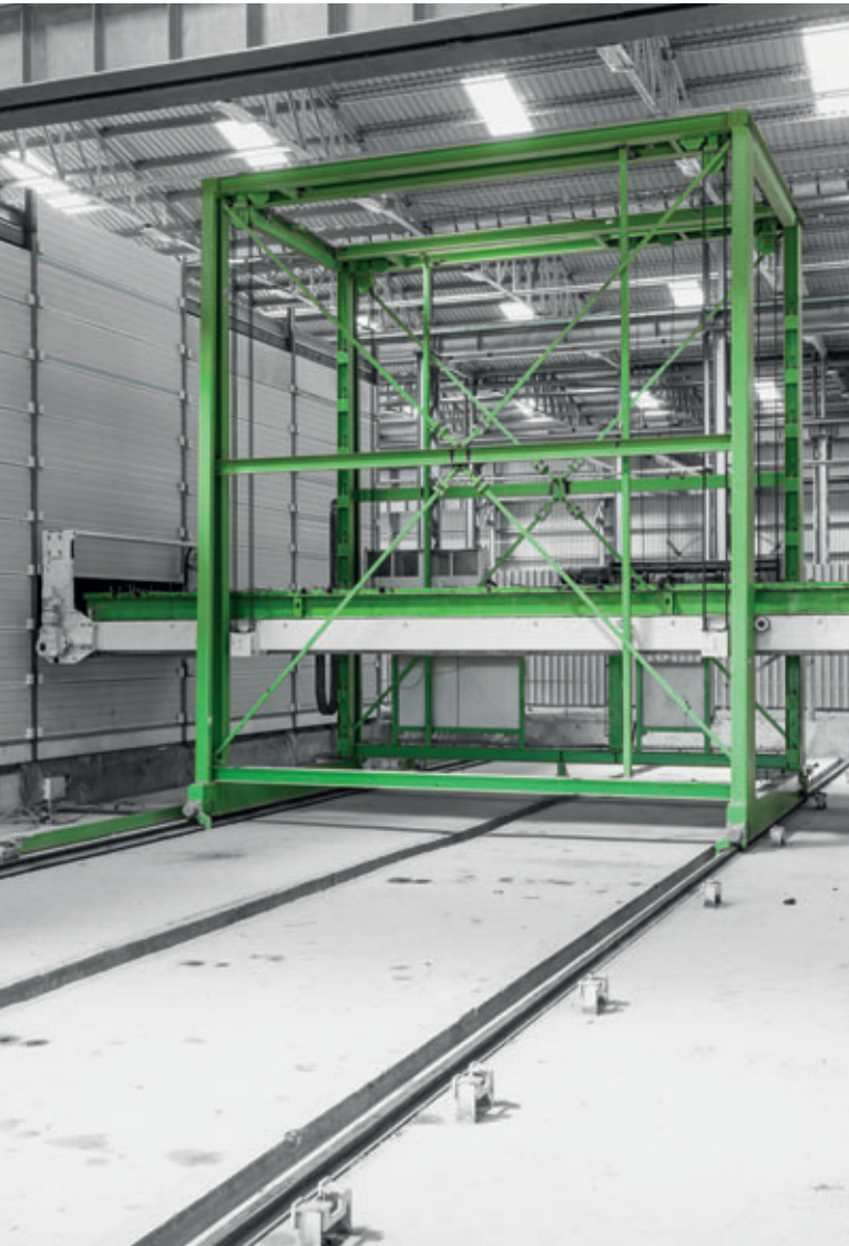
BGSCTPL hat vor kurzem drei Produktionslinien von Elematic in Delhi für Betonfertigteile errichtet: Umlaufanlagen für große Deckenelemente, spezielle Wandplatten und 3S-Stützen.
