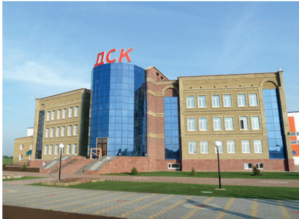
TOO „Kostanay-MBI“ ließ in Kasachstan neben einem neuen Betonfertigteilwerk auch ein neues Bürogebäude entstehen. Sämtliche Fußwege wurden mit Pflastersteinen optisch ansprechend gestaltet aus der dazugehörigen Betonpflasterstein-Produktion.
