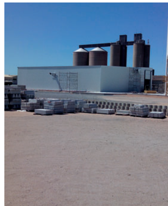
Außendämmung der Härtungsregale, Schnelllaufvor und Umluftsystem nach der Fertigstellung.
