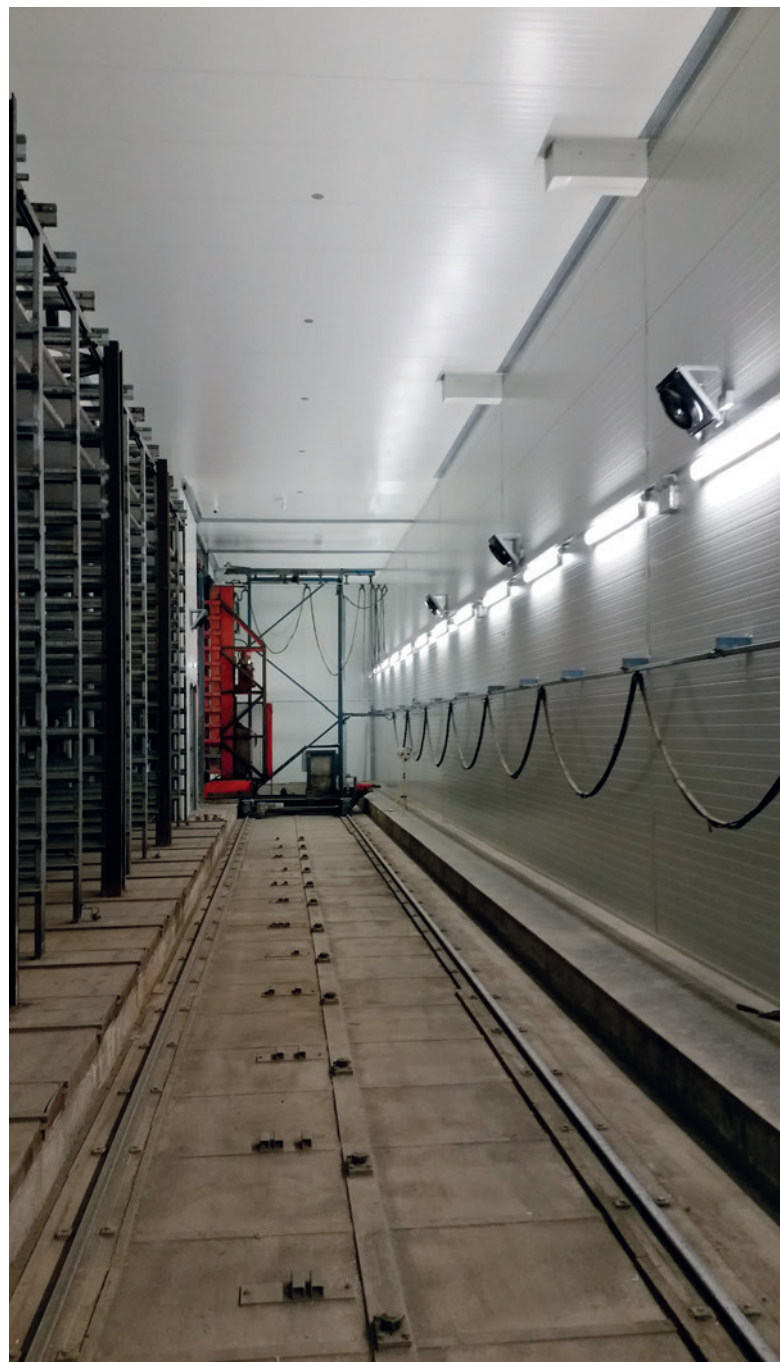
После: изолированные стены и потолок, система циркуляции воздуха и система освещения
