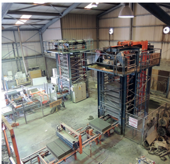
До: зона элеватора и опускного устройства с платформами техобслуживания
