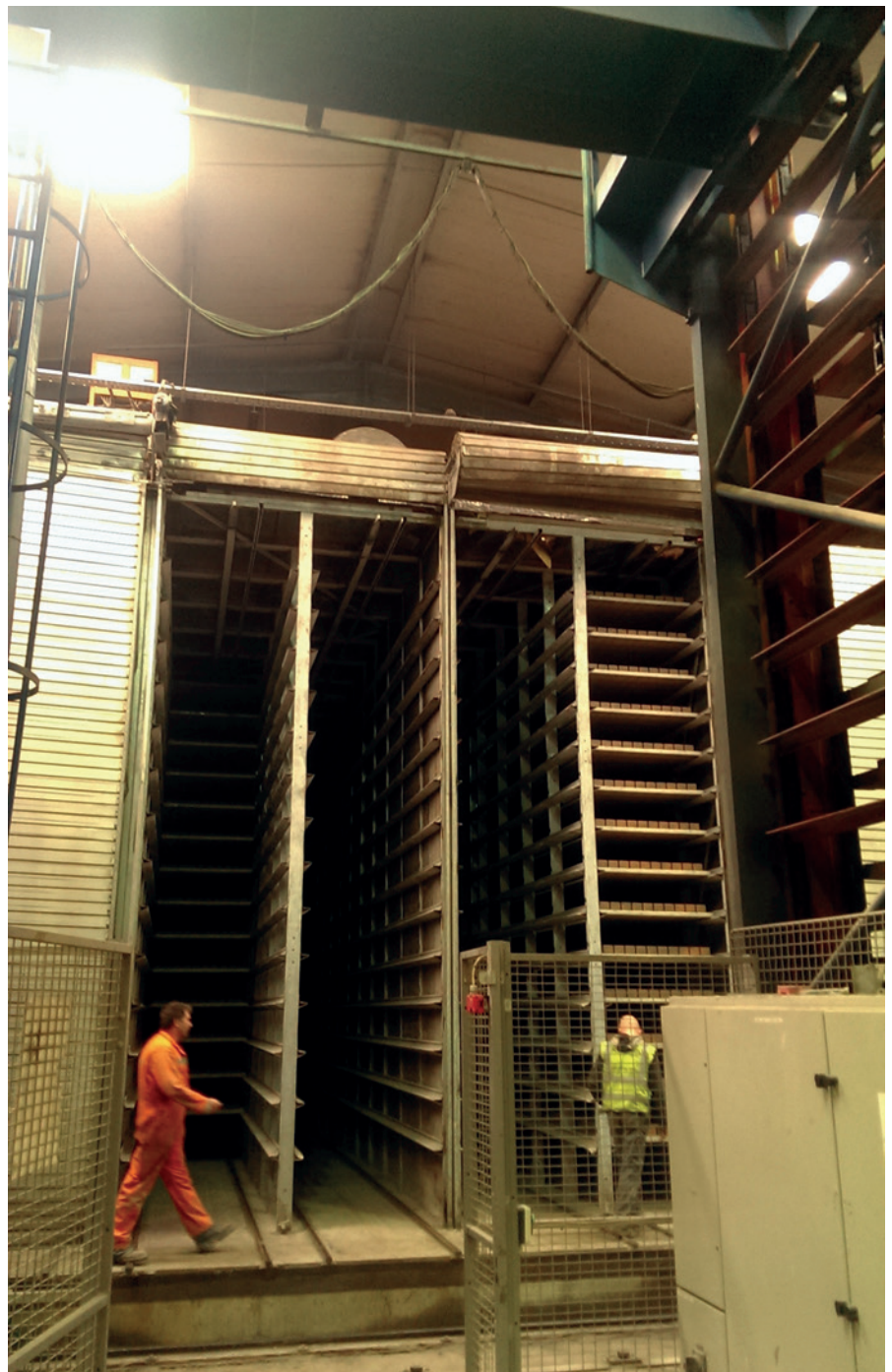
До: эlevator и опускное устройство, стеллажи и жалюзийные шторы двери
