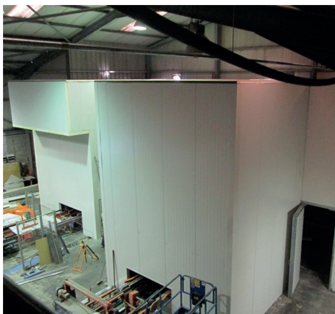
После: элеватор и опускное устройство изолированы. Место для платформ техобслуживания
