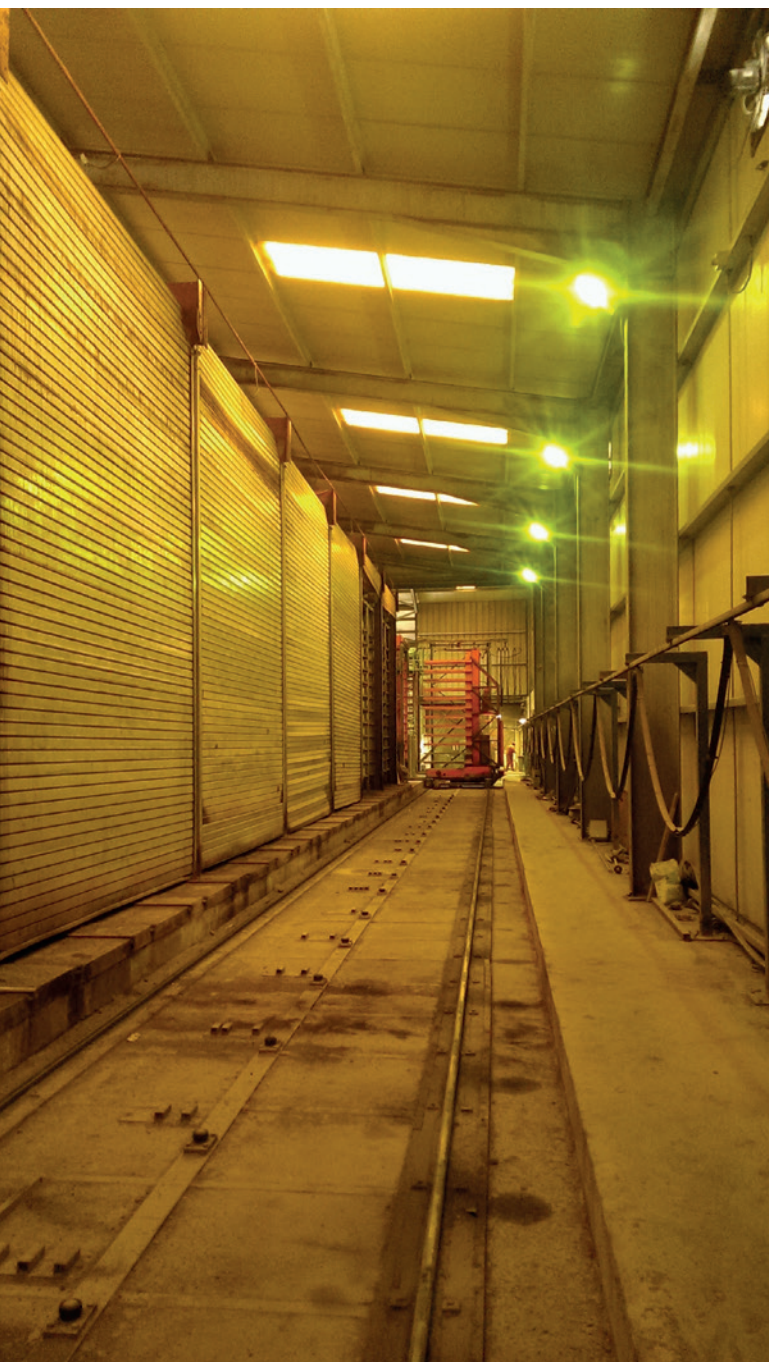
До: участок с передаточной тележкой, тепловая изоляция и жалюзийные двери
