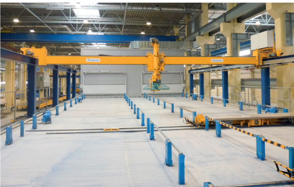
После предварительной выдержки подъемная платформа транспортирует поддоны на второй ярус, оборудованный затирочной машиной и четырьмя постами для заглаживания
