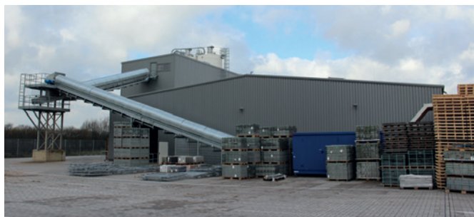
На двух ленточных транспортерах шириной 800 мм (длиной 34 и 22 м) инертные доставляются на верхний ярус встроенной в цех башенной бетоносмесительной установки
