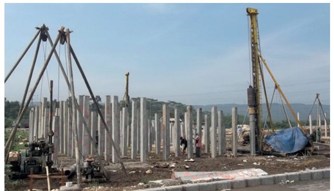
Укрепление грунта путем забивки бетонных свай
