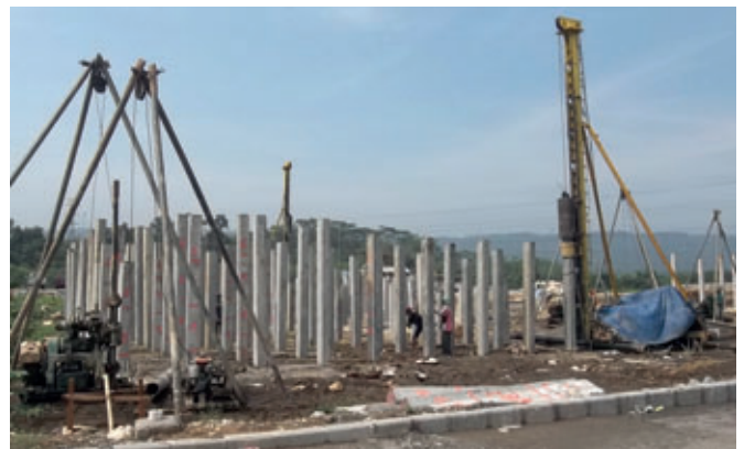
Stabilizzazione del terreno edificabile grazie ai piloni in calcestruzzo
