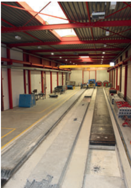
Aperçu d'une ligne de production de l'usine de démonstration d'Echo Precast Engineering
