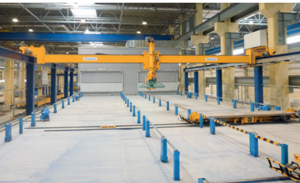
Après la prise du béton dans la chambre de prétraitement thermique, la plate-forme de levage transfère les palettes au second niveau. Ce niveau abrite une truelle mécanique et quatre emplacements de lissage pour la finition.
