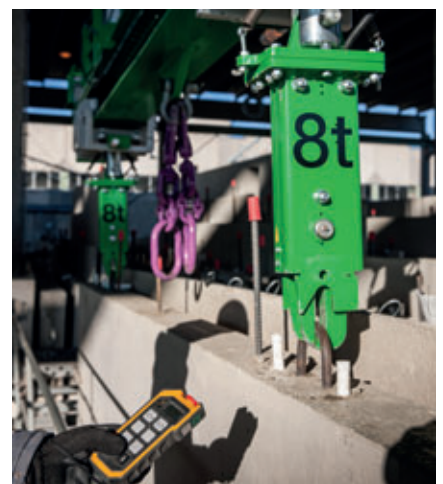
La longue et ardue mise en place des chaînes est inutile puisque le palonnier de levage Elematic est doté de crochets de levage.
