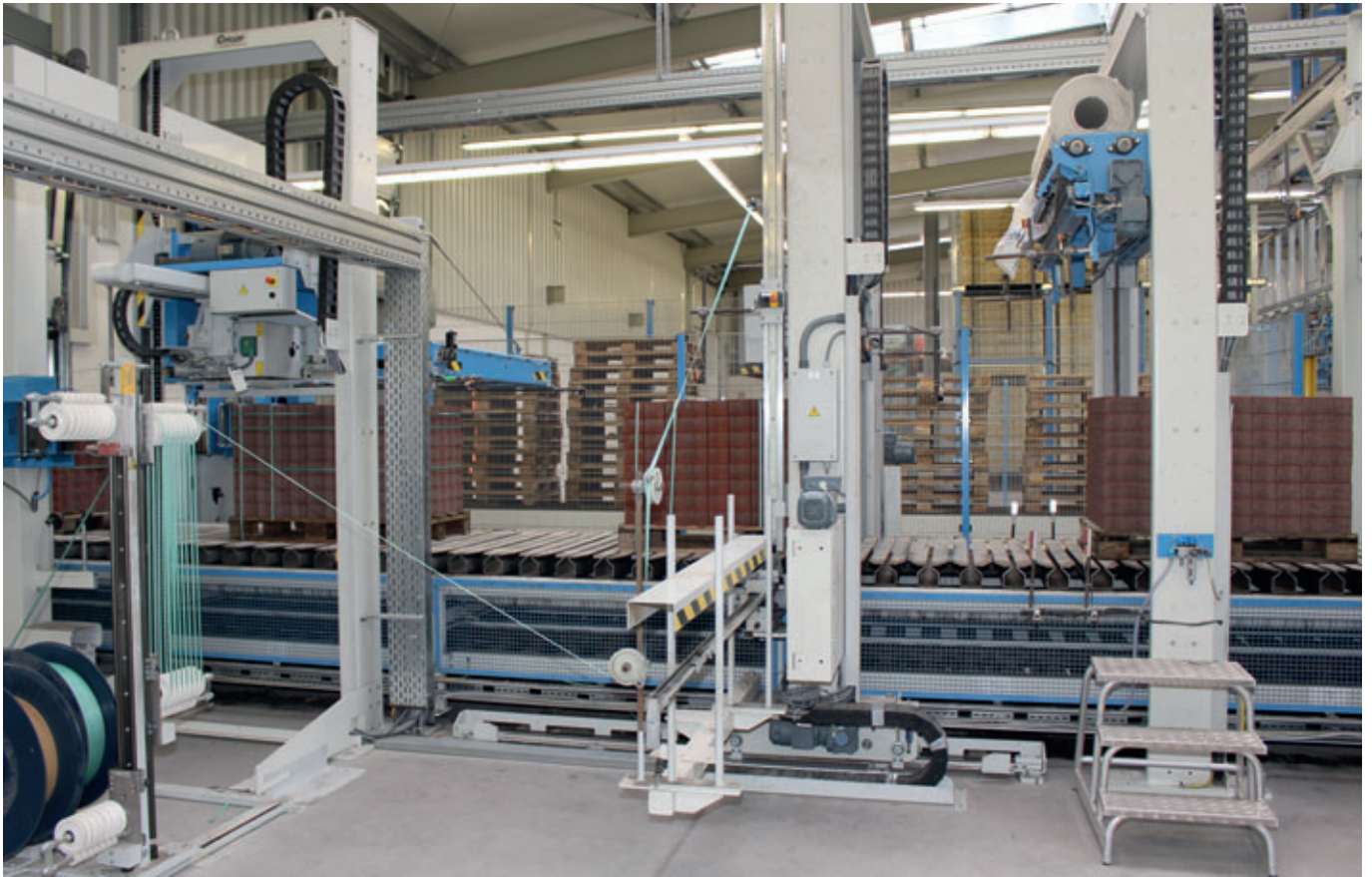
Les paquets de blocs finis sont cerclés horizontalement et verticalement, puis sont transportés dans la zone extérieure du hall.
