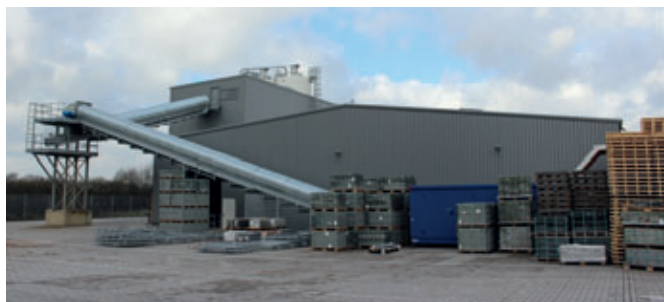
Les granulats sont transportés dans le niveau le plus élevé de la tour de malaxage intégrée dans le hall au moyen de deux bandes transporteuses de 800 mm de large (34 et 22 m de long).
