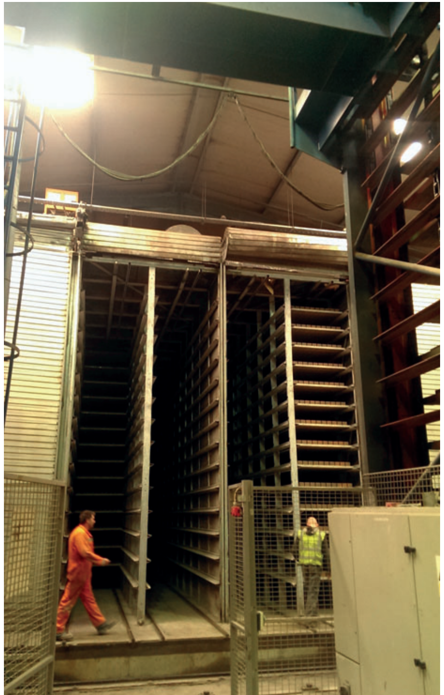
Antes: Zona del carro multitorca junto al ascensor
