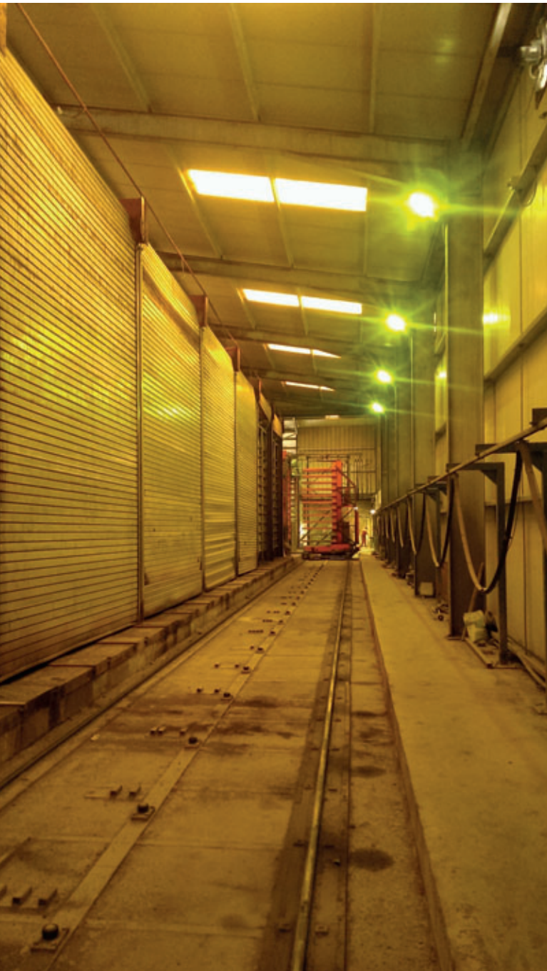
Antes: Aislamiento del edificio y puertas enrollables
