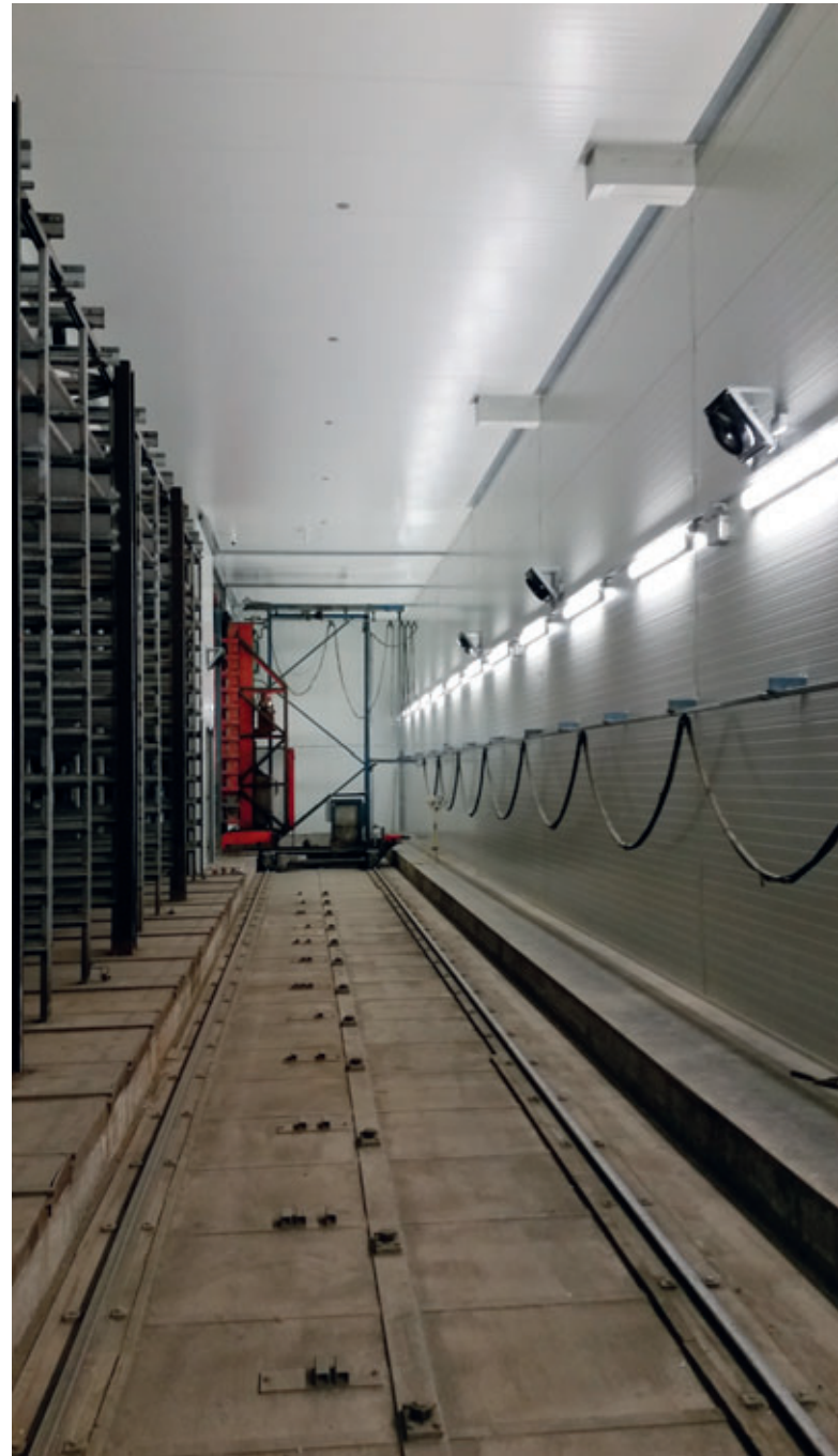
Después: Paredes y techo aislados, circulación de aire e iluminación
