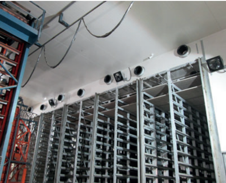
Después: Zona del carro multiforca completamente aislada, con circulación de aire y suministro de aire caliente
