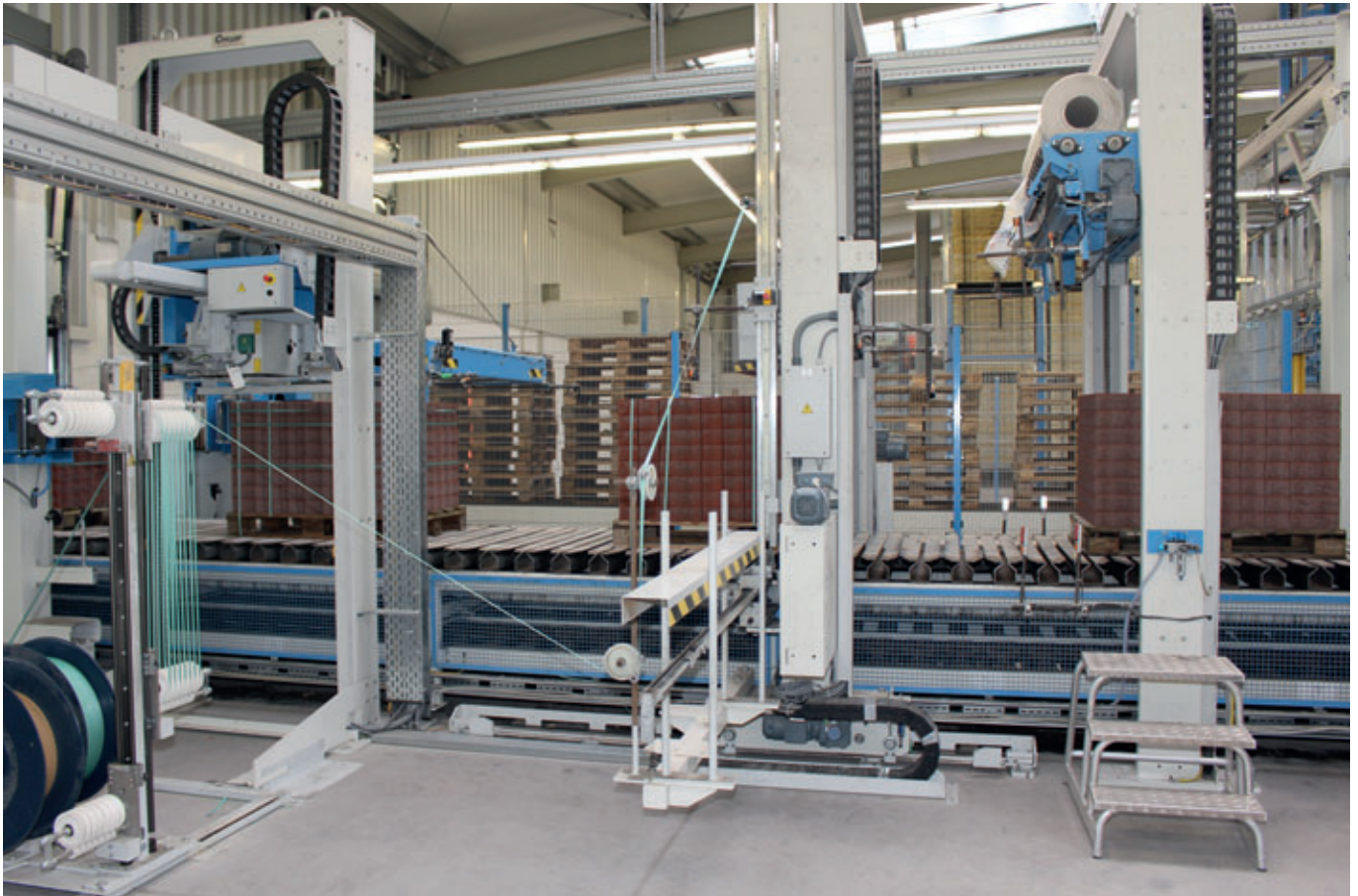
Los paquetes de bloques listos son flejados a continuación horizontal y verticalmente y luego transportados a la zona exterior de la nave.
