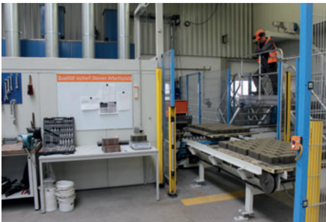
Para el control de calidad se pueden desviar bandejas individuales de la línea de producción, directamente detrás de la máquina de producción de bloques.
