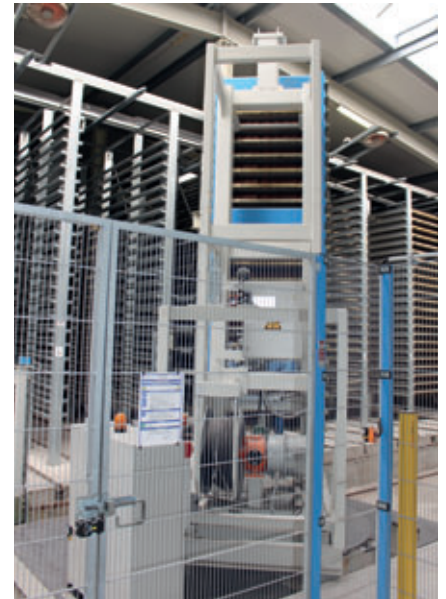
La instalación de estanterías fue concebida como solución para grandes espacios y adaptada exactamente a la nave.
