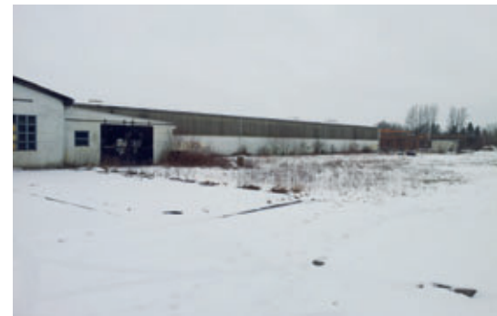
Esta antigua nave fue transformada por Lithonplus en una planta de producción altamente moderna.
