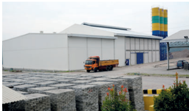
La nueva fábrica, aproximadamente 100 kilómetros al sudeste de Yakarta
