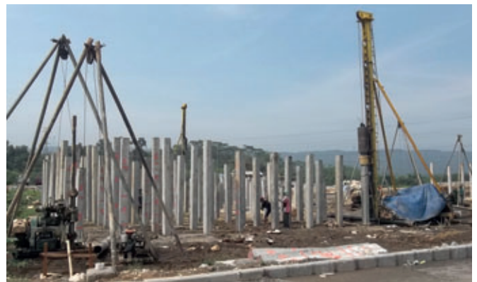
Estabilización del terreno con pilotes de hormigón
