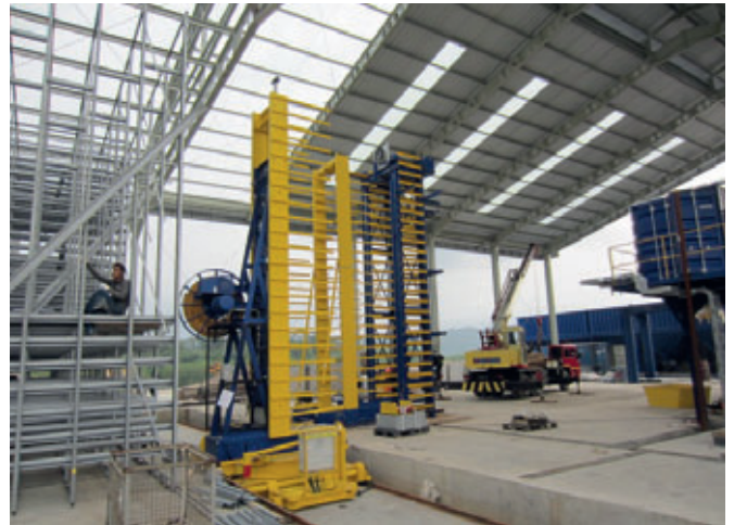
Montaje de la nueva instalación de estanterías para la cámara de curado
