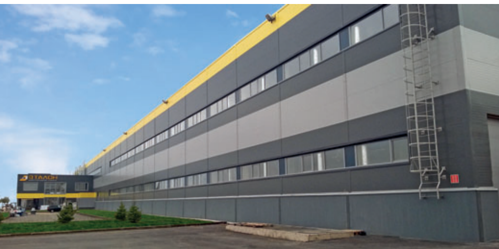
Die neue und repräsentative Produktionshalle vom Werk DSK Etalon umfasst eine Gesamtfläche von 13.000 m 2 .
